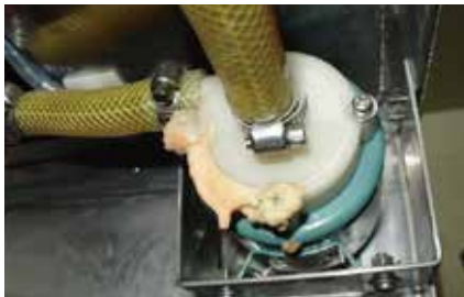
ポンプからの液漏れ
