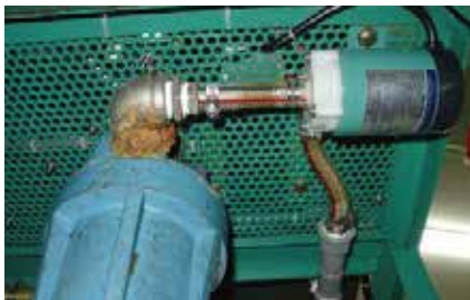
フィルターハウジング上部からの液漏れ
