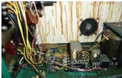
電装部への液漏れ
